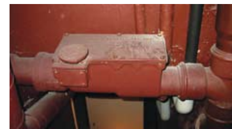
Äldre gjutjärnsrör (så kallade normalrör) med renslucka där slamprov kan tas. Luckorna kan vara svåra att öppna och åter få helt täta.
