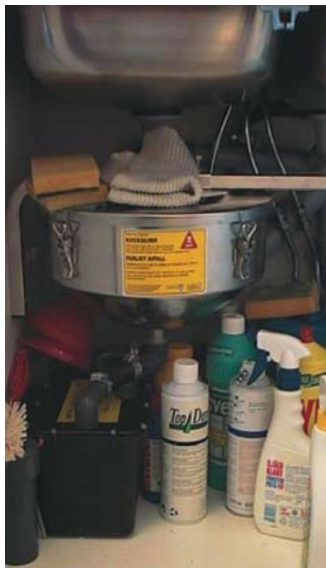
En bufferttank bör installeras under vasken för att hindra att genomströmningshastigheten blir för hög genom avskiljaren.
